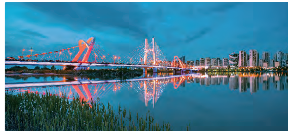
▲ 汉中龙岗大桥
