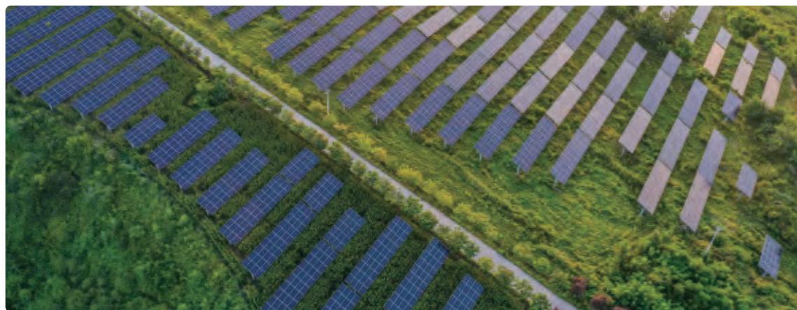
▼ 铜川宜君县刘家崧光伏电站
